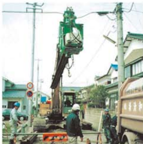
▲電力・電話線・高架下での施工。
