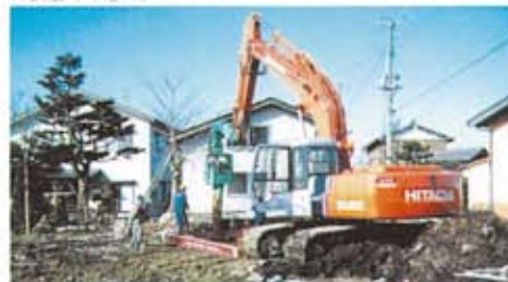
▲家屋近接での施工。
